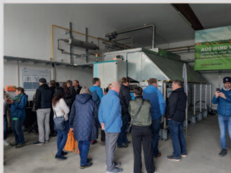
Power2Gas-Anlage bei den Stadtwerken Haßfurt
