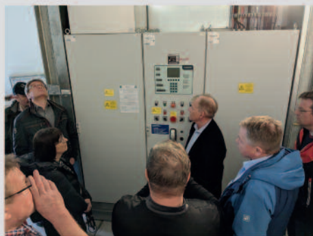
Schalttafel im Inneren eines Windrads
