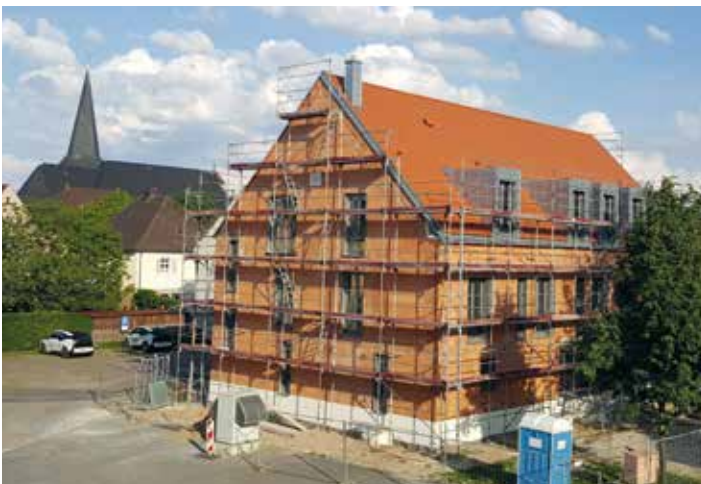
Die Ziegelbauweise des neuen Rathauses hilft Energie zu sparen © Markt Buttenheim
